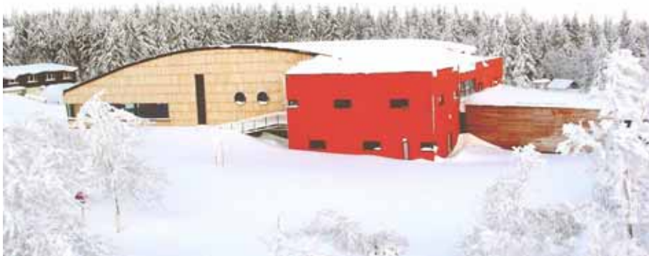
Tief verschneit ist die Wasserkuppe, als fröhlicher Farblecks leuchtet unser Neubau hervor. „Zugang nicht möglich“, schreibt unser Fotograf, aber die Dachlast scheint erträglich zu sein, dank des Windes, der ständig dort oben weht. Foto: O. Becker
